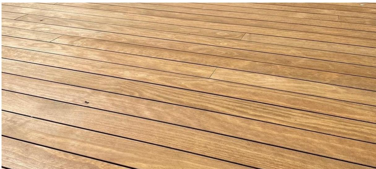
*DECKiBOIS commercialise des lames de terrasse en Kebony avec le concept GRAD pour les lames à clipser en section 21 x 120mm mais aussi des lames à visser en section 21 x 145mm.*
